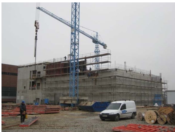
Abbildung 19: Baustelle ZDW am 09.12.2008
