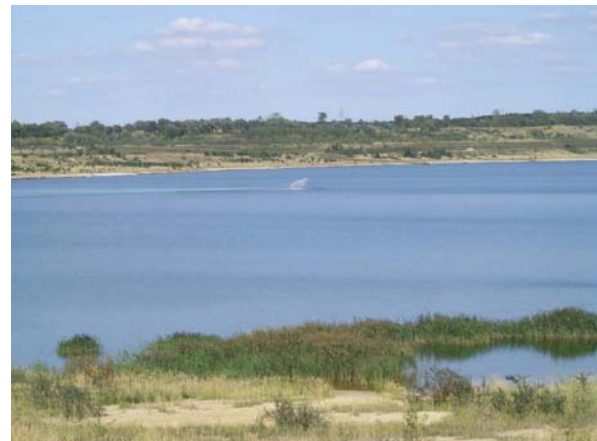
Abbildung 20: Pilottest im Hainer See zur Seewasserbehandlung. Dabei wird Kalkmilch direkt auf dem See verregnet.
