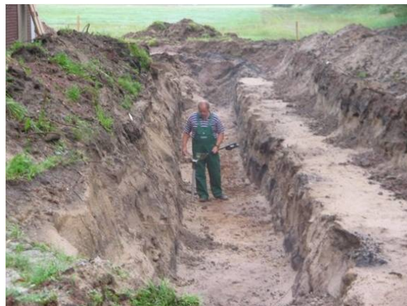
Abbildung 11: Kampfmittelräumung durch Abtrag von Boden und nachfolgender Sondierung
