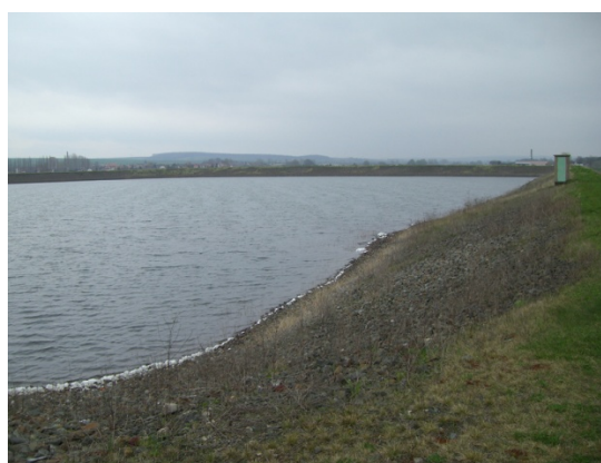
Abbildung 18: Sole-Speicher Wipperdorf (April 2008) vor Erneuerung der Sohlabdichtung
